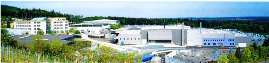
Frisch erweitert: Der Familienbetrieb Layher aus Göggingen-Eibensbach mit inzwischen 1100 Mitarbeitern weltweit beschäftigt sich mit dem Thema Gerüst seit Generationen Tag für Tag. Bilder: Layher
